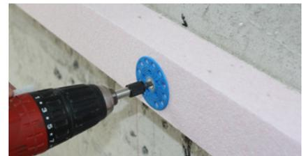
Beachtung der Randabstände für die zusätzlich mechanische Befestigung: ca. 0,1 m von der Kante entfernt und mittig der Montageleiste.
