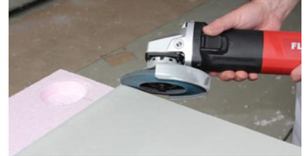
Das zugeschnittene Faserbetonelement ist für die Verbindung mit einem Riffelblech zu versehen. Dafür muss der Dämmstoff an der Übergangseite zum Faserbeton mit einer Öffnung versehen werden. Die Öffnung muss mind. 4 mm breit und mind. 40 mm tief sein.
