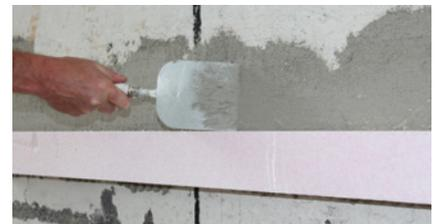
Die Fugen der Faserbeton-Montageleiste und die Fuge der Faserbeton Sockelelemente müssen im Versatz verlegt werden. Es ist ein Versatz der Fugen von mind. 10 cm sicherzustellen.
